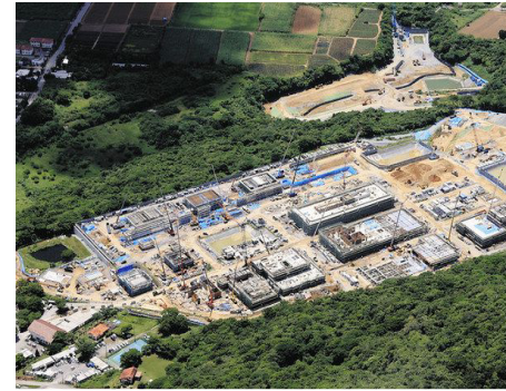
建設中の陸自石垣駐屯地
