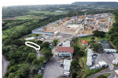
石垣島平得大俣の陸自ミサイル基地建設工事現場（22年1月）
